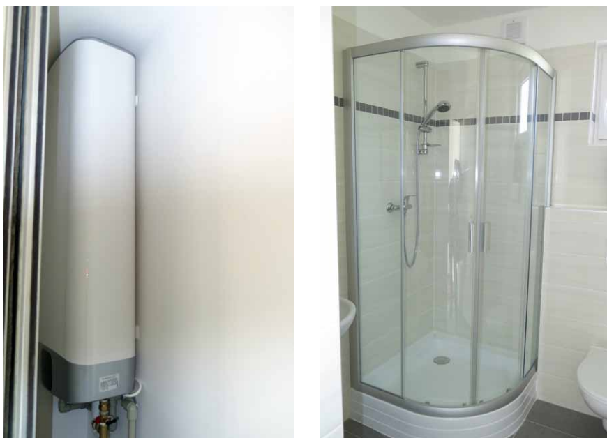
Základní modul KÚLNY s technickým a hygienickým zázemím, prezentovaný v Brně, byl tam i zpět bez úhony transportován...
