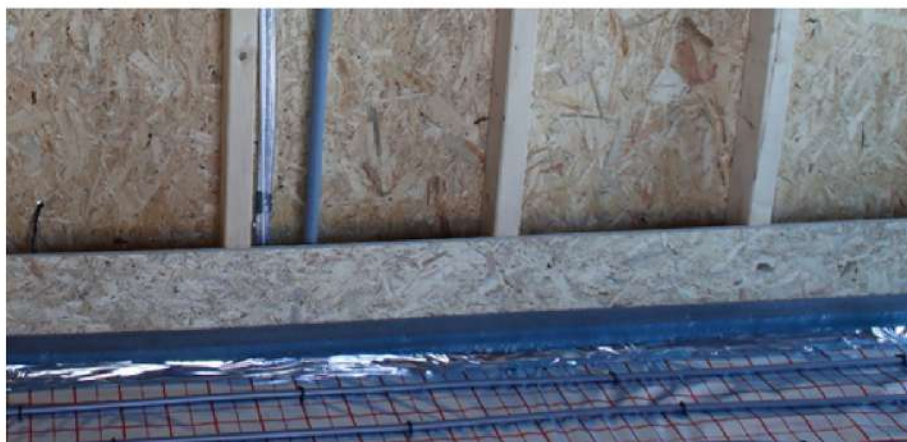
Obr. 41: Částečné zaklopení příčky
