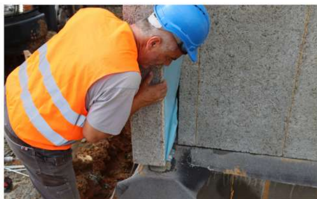
Obr. 10: Osazení panelu na základovou desku
