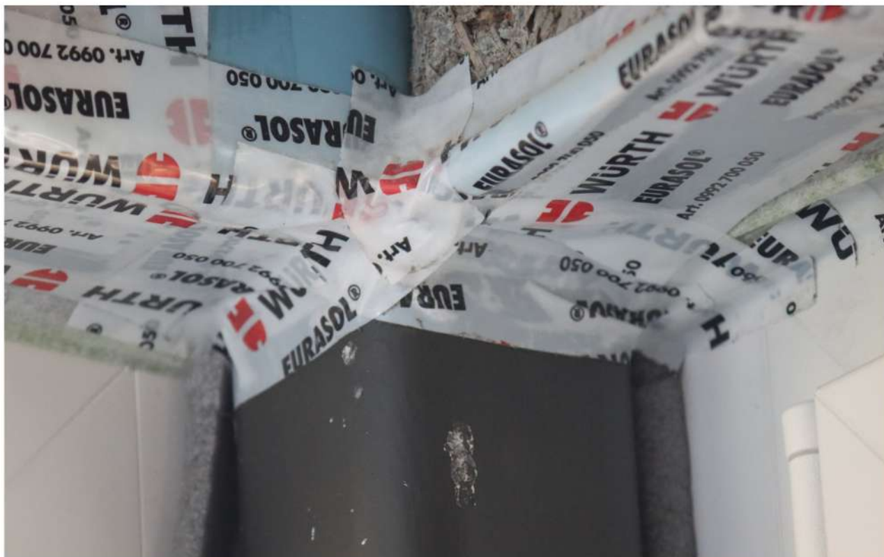
Obr. 34: Detail napojení parotěsných folií u oken
