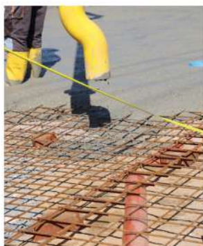
Obr. 4: Základová konstrukce a podkladní deska
