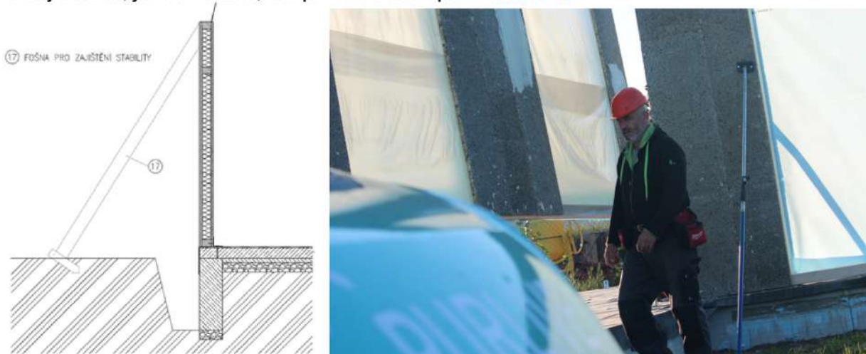
Obr. 12: Fošna pro zajištění stability
